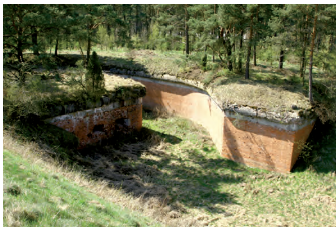
Fot. 2. Twierdzę Osowiec nad Biebrzą – rosyjską fortyfikację nowożytną – zaczęto budować we wrześniu 1882 r. jako umocnioną pozycję zaporową, obejmującą trzy forty: Fort I – „Centralny” (najstarszy, z koszarami), Fort II – „Zarzeczny” (najbardziej wysunięty na północ od Osowca) i Fort III – „Szwedzki” (artyleryjski), obecnie w zarządzie Nadleśnictwa Knyszyn (RDLP Białystok)
