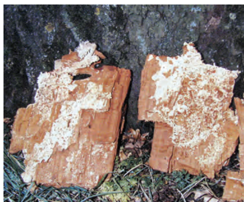
Fot. 131. Huba żółciaka powoduje destrukcyjną zgniliznę z białymi plamami skórzastej grzybni, przerastającymi spękania drewna
